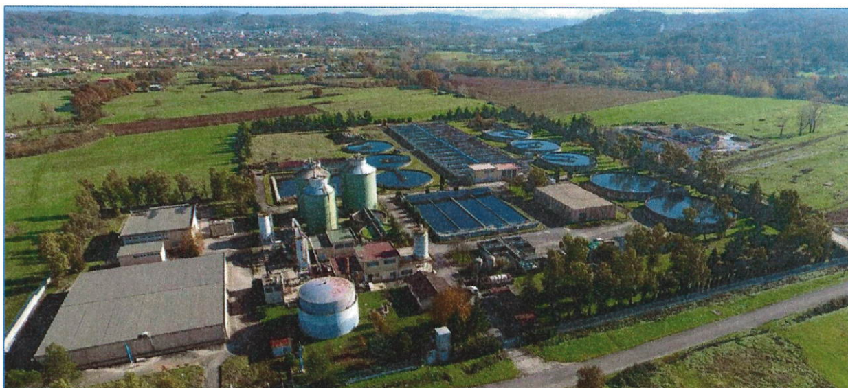
IMPIANTO DI DEPURAZIONE CONSORTILE LOC.TA' COLLE SAN PAOLO CECCANO (FR)
